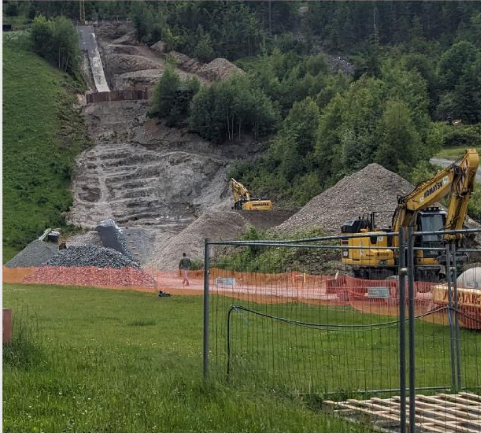
Ausbau der kompletten Auffüllung, Abtransport Haufwerk
